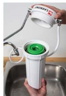
7. Stellen Sie den Hebel am Umlenkventil waagrecht und öffnen Sie den Wasserhahn. Das Filtergehäuse wird nun entlüftet.
